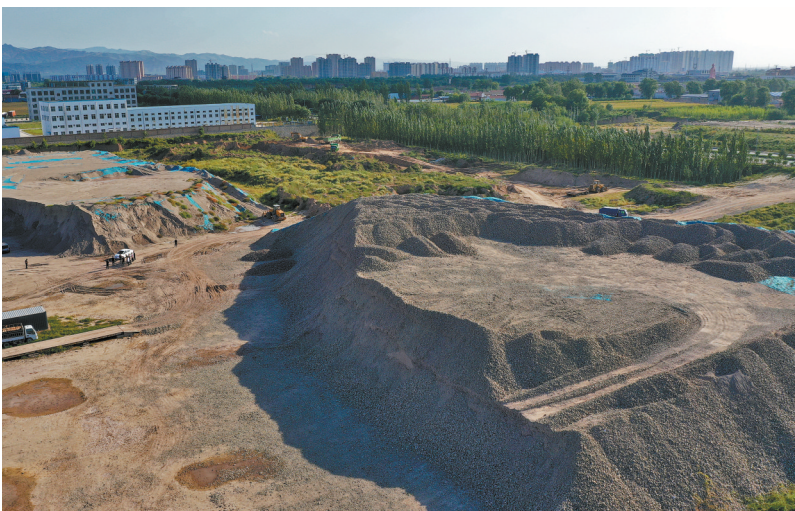
太谷区水秀镇团场村临时物料堆场未苫盖存在扬尘污染。
