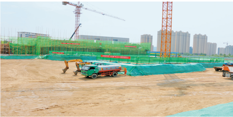
施工现场所有裸露位置进行了滤网覆盖 郑涛 摄
