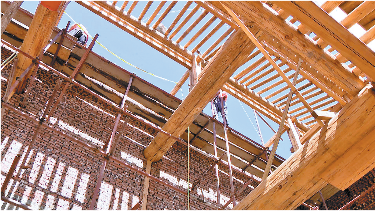
太谷古城南大街修缮施工点 王元龙 摄
