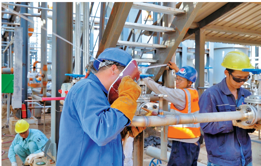
昌盛集团25万吨焦炉煤气制备甲醇项目施工现场。 雷浩 摄
