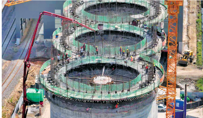
丰安专用铁路工程精煤筒仓施工项目。 马子为 摄
