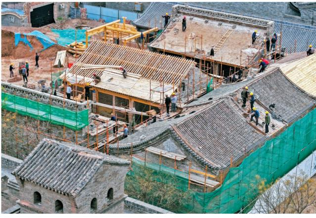
4月7日,在平遥古城新建二级消防站建设工地,工人正在加紧施工。该工程位于平遥古城内,占地3646平方米,按照明清院落建筑风格设计,采用传统建房工艺施工,共有大小建筑25座,均为砖木结构,与平遥古城整体风貌一致。 本报通讯员 梁生仁 摄
