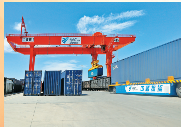
中鼎物流园集装箱作业区。
