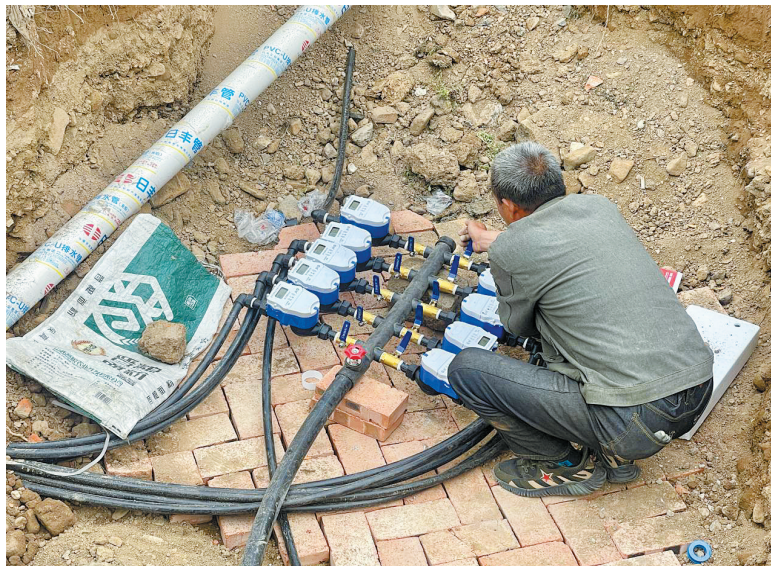
工人师傅正在安装阀门井附属设施。
