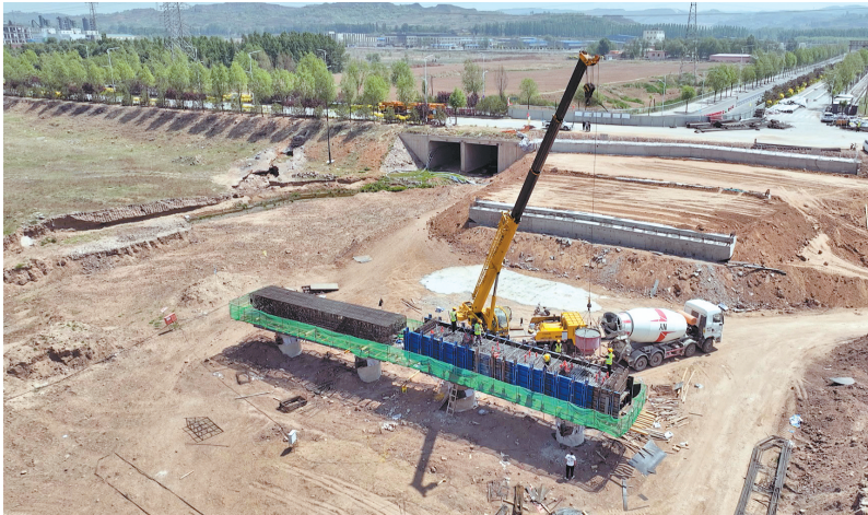
太行一号旅游公路榆社县旋余沟村—(北王村)湿地公园公路改建工程施工现场。 本报通讯员 常新雨 摄
