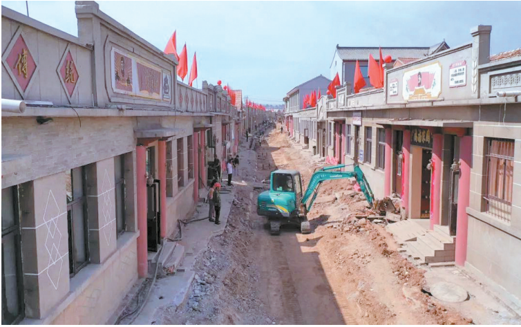
红旗一条街管网改造工程施工现场挖掘机开沟挖槽。 张渊杰 摄
