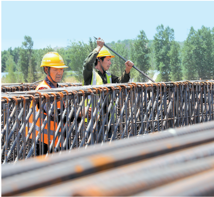
7月10日,在榆社县湿地公园改建现场,工作人员正在加紧施工,确保工期按时完工。近年来,该县坚持“生态立县”战略定位不动摇,将生态保护、生态治理与旅游发展有机结合,推动县域经济高质量发展。本报记者 谢晋 摄
