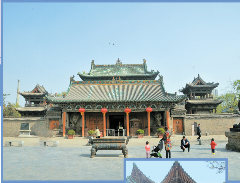
上图：榆次城隍庙 右图：琉璃瓦顶
