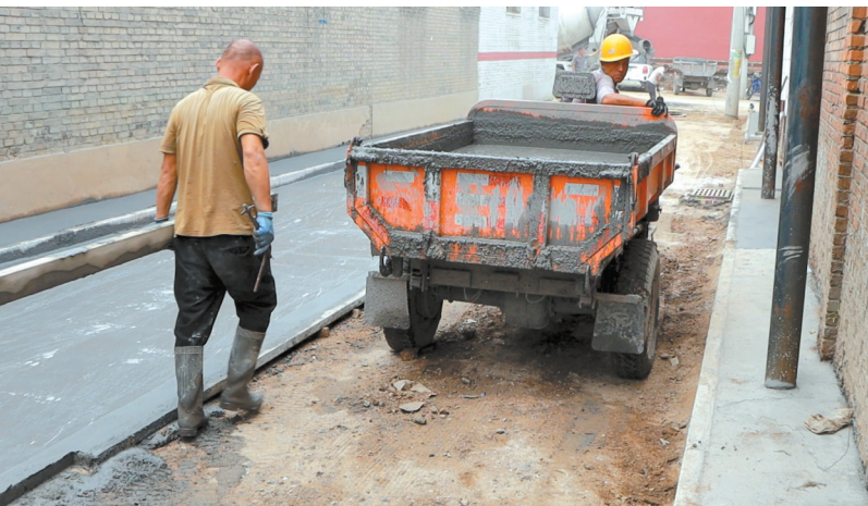
义棠镇北村道路建设施工现场。 李伟明 摄
