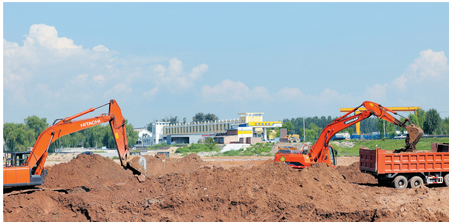
8月13日,平遥县惠济河人工湿地水质净化工程正在紧张施工。该项目是平遥县“一泓清水入黄河”重点项目之一,主要建设内容包括垂直湿地、沉沙池、沉淀池以及提升泵站、管理房等相关附属设施,建成后日处理能力可达3万吨。 本报记者 刘勇 摄
