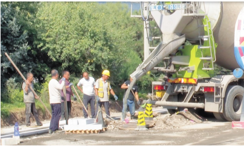
(赵慧 王玮) 铺筑沥青混凝土现场。 王玮 摄
