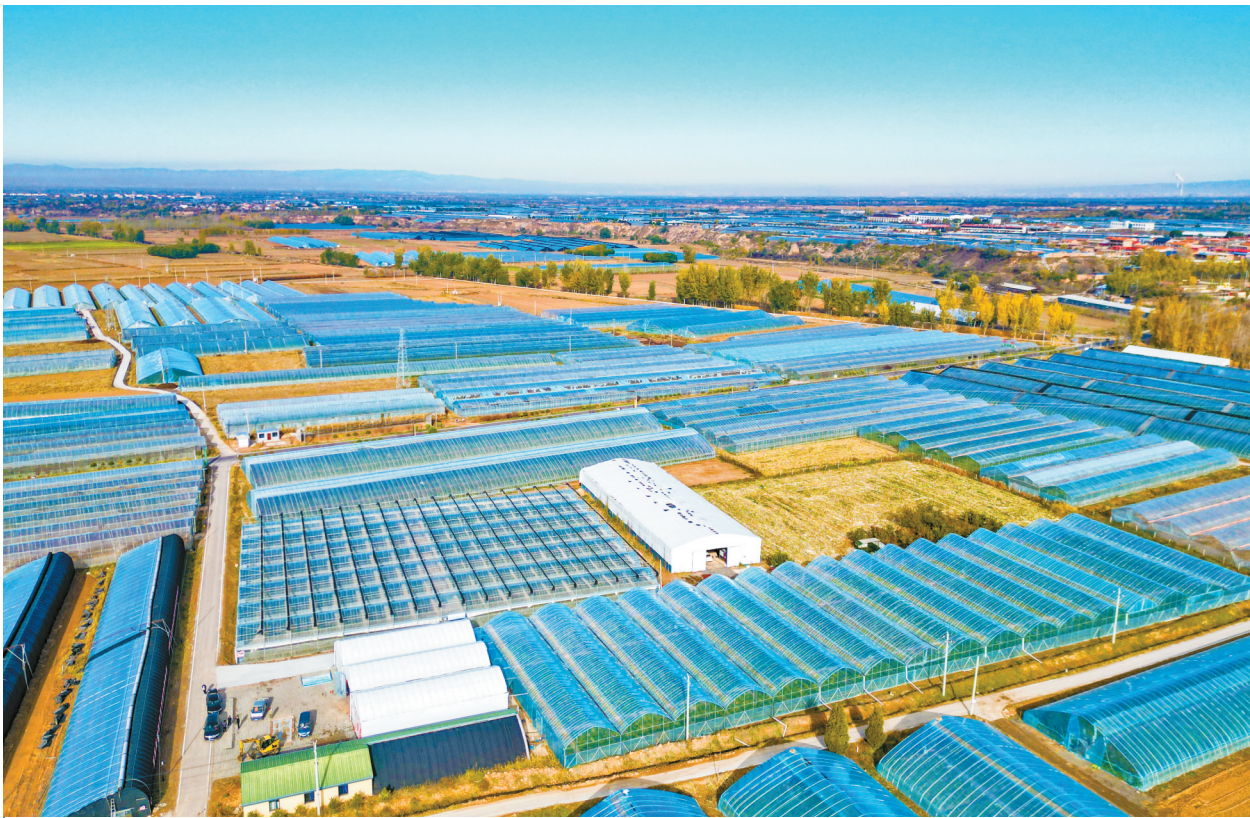
近年来,太谷区通过创新种植方式、引进优良品种、推广运用先进种植技术等方法,不断推进农业规模化、集约化、机械化、设施化、智慧化水平,促进农业增效,农民增收。图为11月3日记者拍摄的规模宏大的太谷区范村镇闫村设施蔬菜产业园。 本报记者 张浩亮 摄
