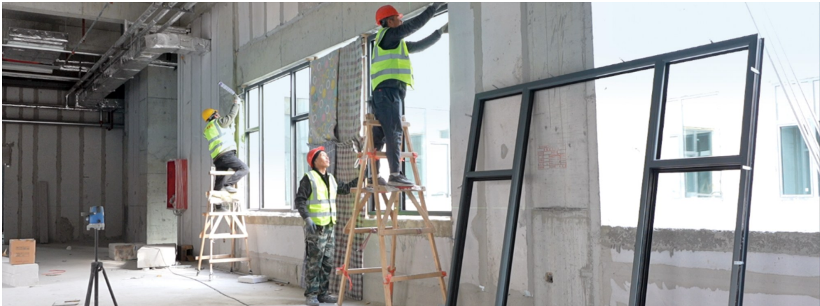
安装主体建筑玻璃等设施。灵石县中医院新建项目施工人员在施工现场
