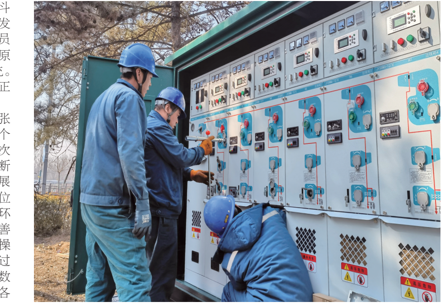
配电人员正在进行作业。 庞博媛 摄
