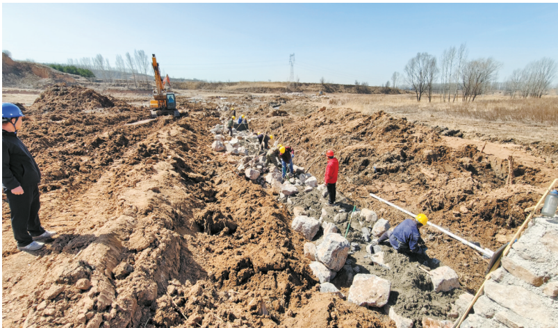
寿阳县龙门河防洪能力提升工程施工现场。
