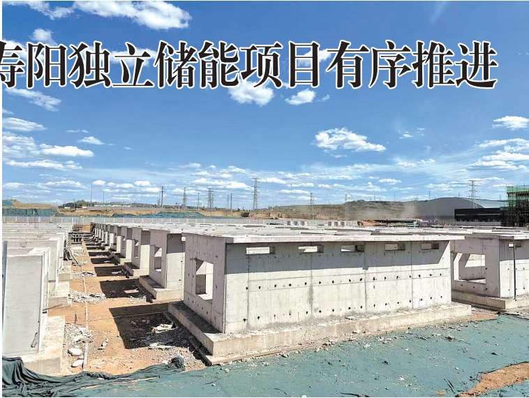
山西融和能储寿阳200MW/400MWh独立储能项目施工现场。李佳蓁 摄
