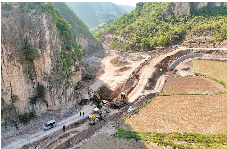
瓮山至黄庵埡旅游路连接线北岩路段,施工现场一派繁忙。 孔令宏 摄
