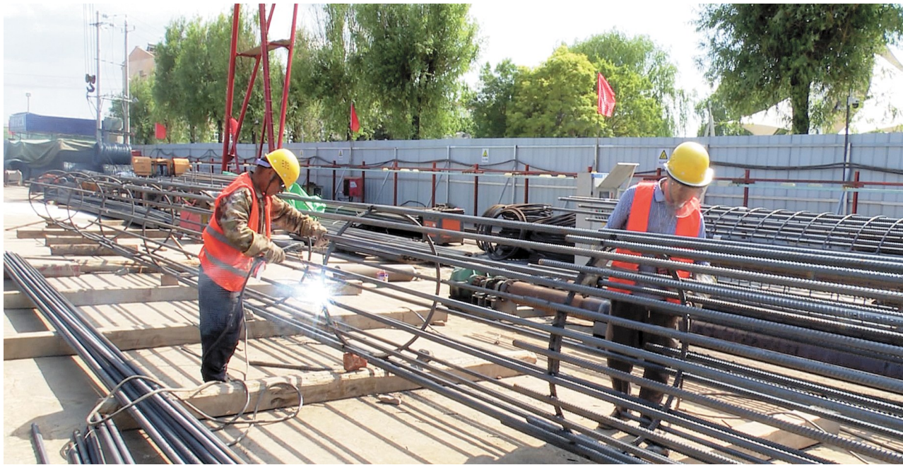
施工人员正在焊接钢筋。 王玮 摄
