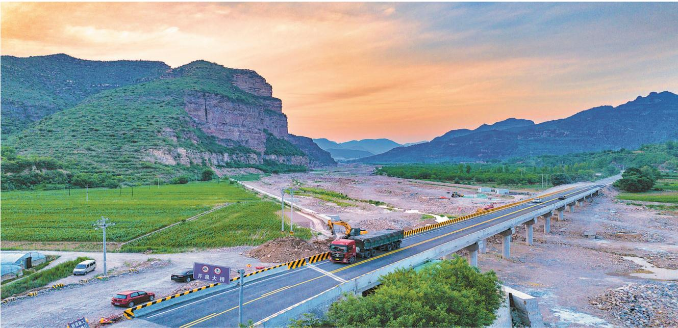
6月24日,国道340线左权县泉梁大桥灾毁重建工程全面完工并正式通车。该工程历时9个月,按一级公路标准建设,全长206米、宽10米,采用混凝土T梁结构。通车前,技术人员通过动静载实验对桥梁稳定性进行
