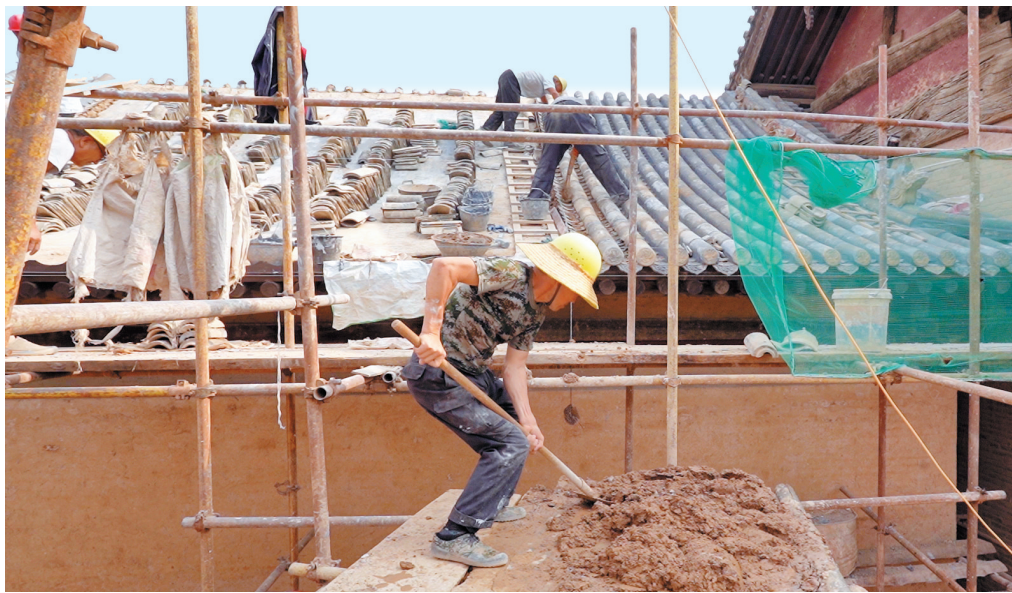
回銮寺东西垛殿保护修缮工程现场。 雷浩 摄
