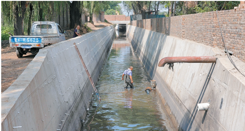
西南排干渠施工现场
