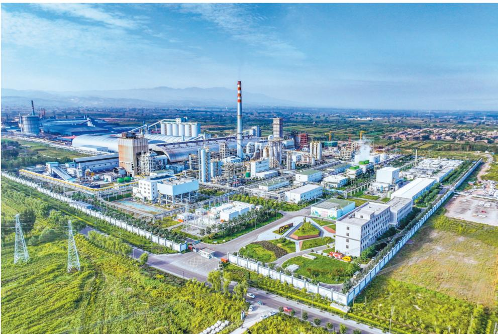
9月8日,平遥煤化(集团)有限责任公司6.25米捣固型焦化改造升级项目正常运行。该项目采用国内先进的捣固装煤推焦一体机炉封装置、人工智能自动分配烟气流、干熄焦烧损自动计算分析等先进设备及尾气低氮燃烧等先进工艺,推动了传统煤化工产业向智能化、环保化转型,实现了产能增长与环保同步的目标。 本报通讯员 梁生仁 摄
