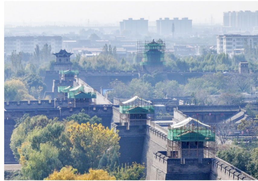
11月2日,在平遥古城东城墙上,工人有序开展敌楼修缮作业。此次修缮工作重点对现存的72座敌楼进行房面防水保护。施工坚持不改变敌楼原状的原则,确保历史风貌不受破坏,并采取分段实施、封闭作业的方式,最大程度降低对游客游览的影响。
