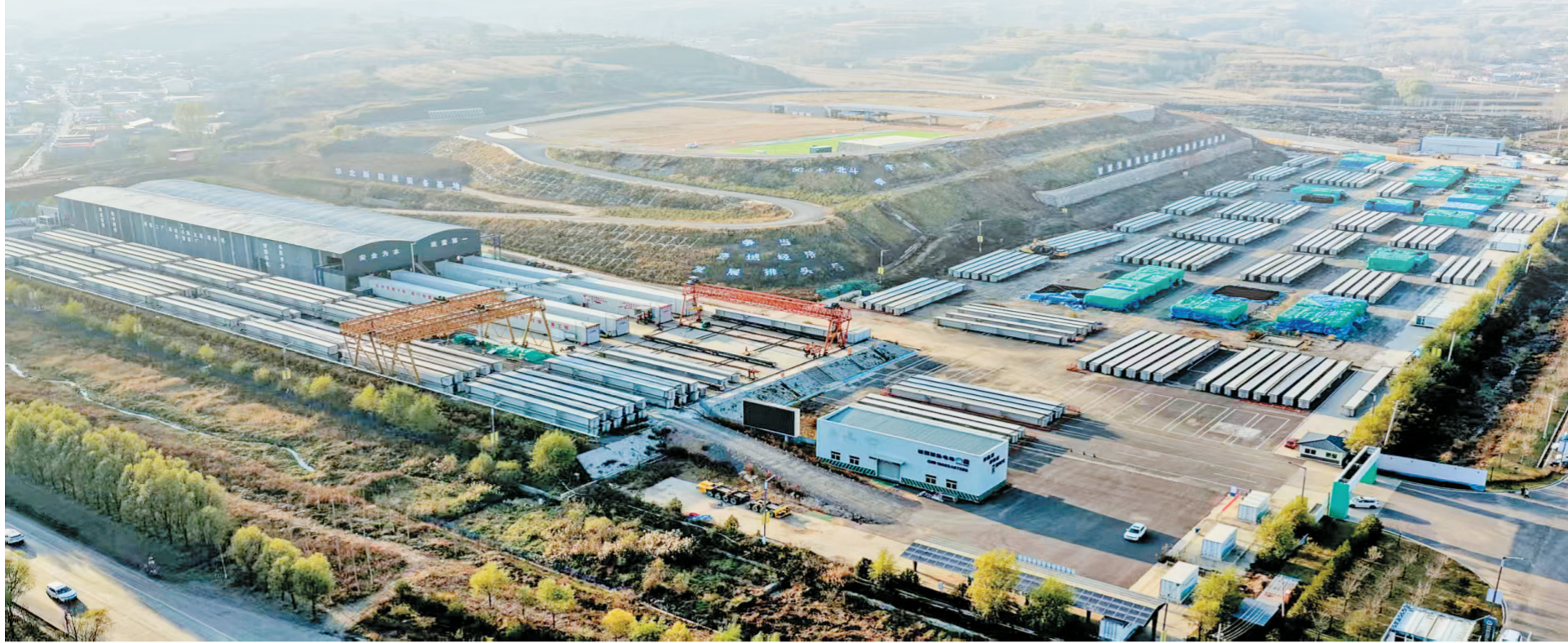
交通智慧物流产业园智慧梁场。 李静 摄
