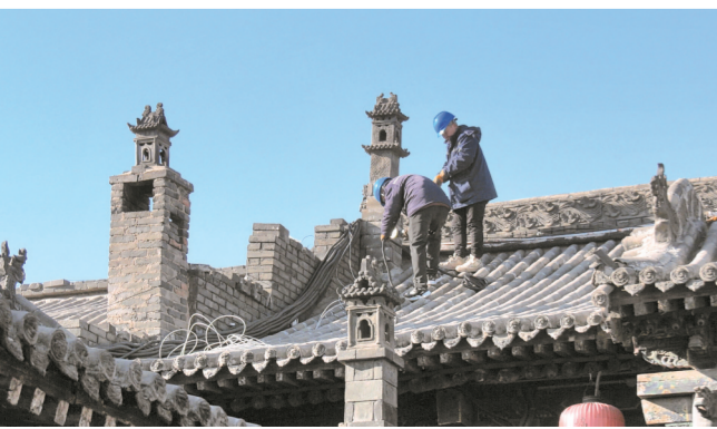
工人们正修缮古城古建筑。
