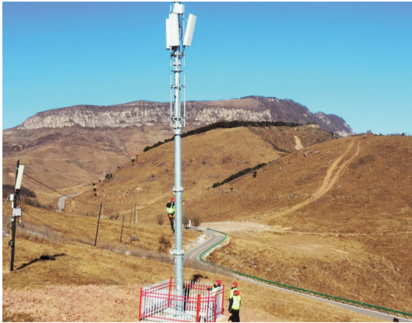
维修人员正在检修走马槽景区5G基站。 张耀月 摄
