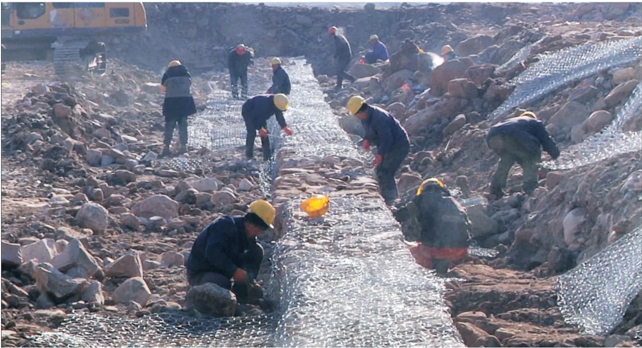
工人们正在进行河道护坡。 李世鹏 摄
