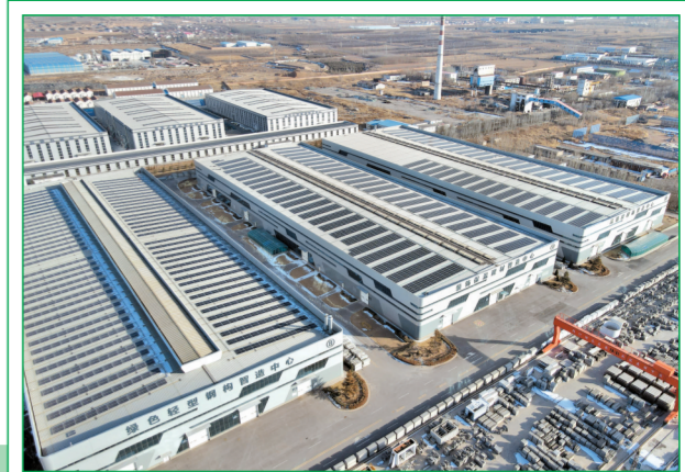
山西建投建筑产业有限公司光伏板铺满车间房顶
