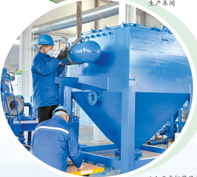
工人正在组装设备
