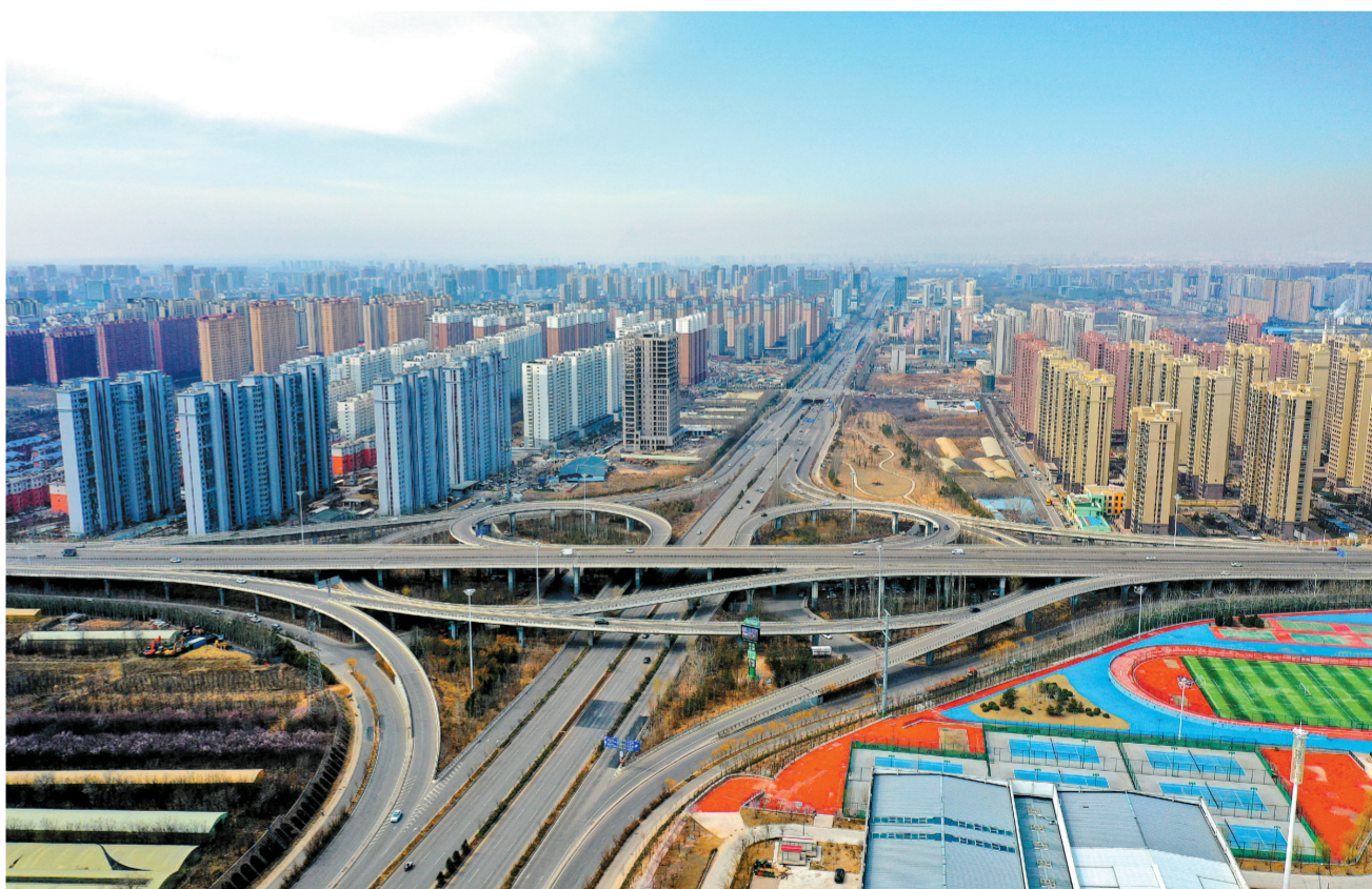
4月2日，俯瞰市城区龙湖街立交桥，纵横交错的匝道如城市“动脉”，串联起城市发展新格局。近年来，我市持续推进交通路网、民生配套等重点城建项目，不断补齐城市功能短板，让城市发展更有温度。 本报记者 刘勇 摄
