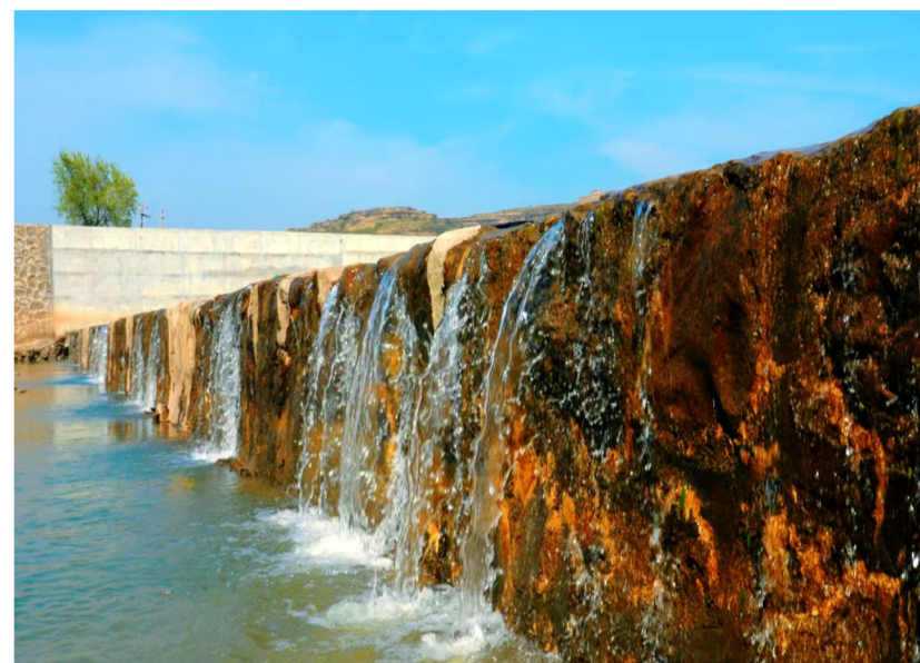
经过全面焕新改造后的龙凤河水清岸绿焕发新生。范亚明 摄
