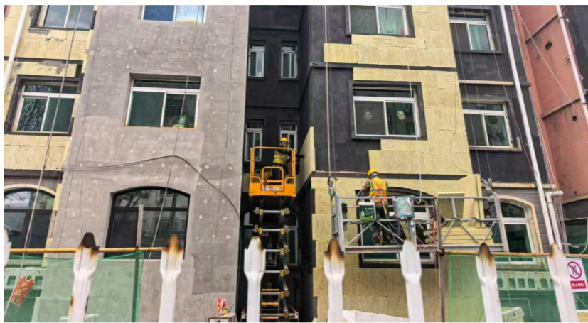
施工人员在保温层为老旧楼栋加装。
