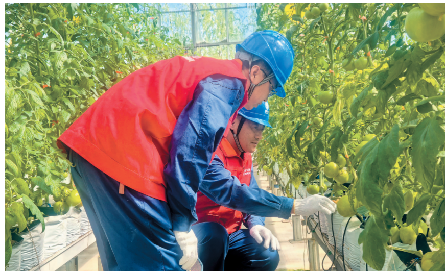
电力工作人员进行线路隐患排查。
