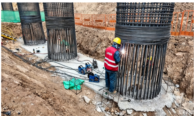
工人师傅们正在进行钢筋焊接。赵慧 摄
