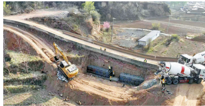
毕路线水毁恢复改造工程施工现场。
