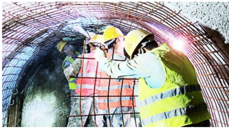
工人们在隧洞掘进作业。
