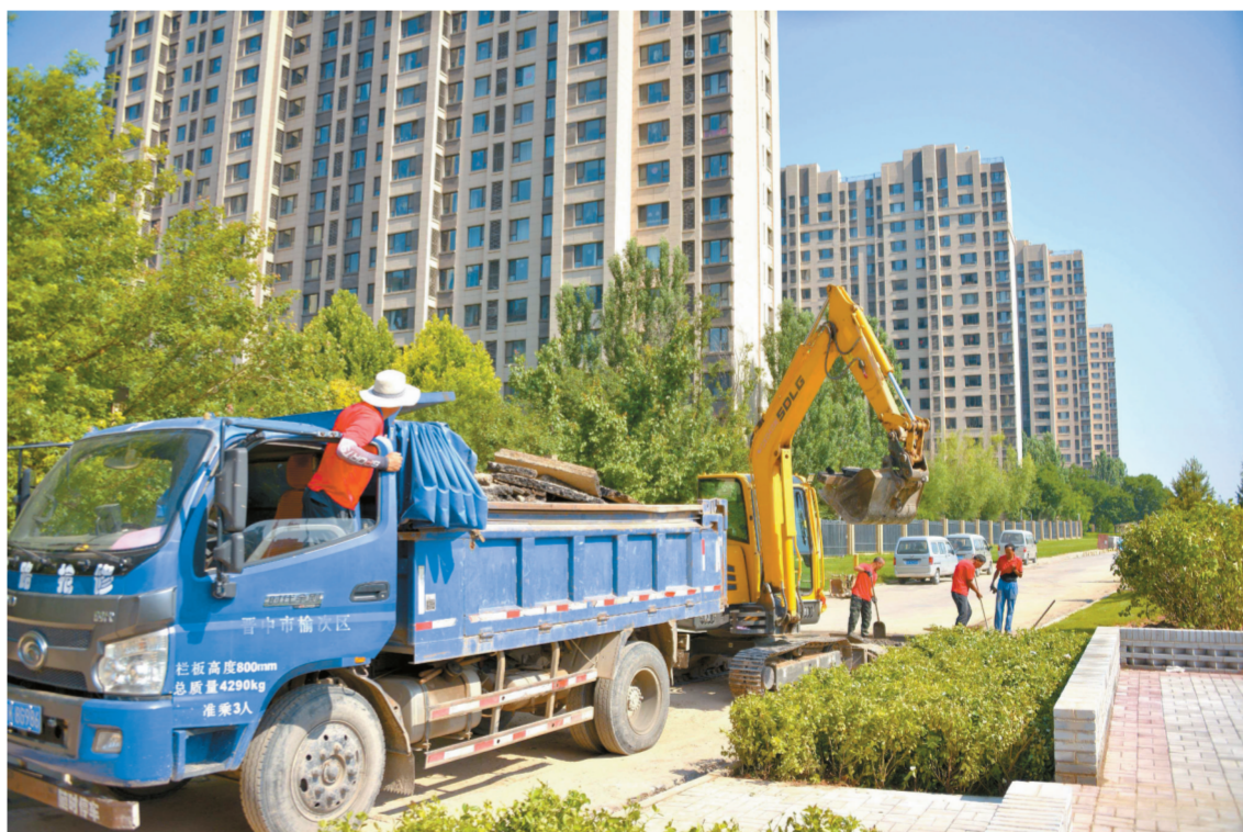
6月12日,晋中市城区龙湖街与锦纶路交叉口机声隆隆,市政工人顶烈日、战高温,清理杂物、整修破损路面,全力整治市容环境,为迎接2026年第二十五届世界U20女子手球锦标赛筑牢保障。 本报通讯员 王东光 摄
