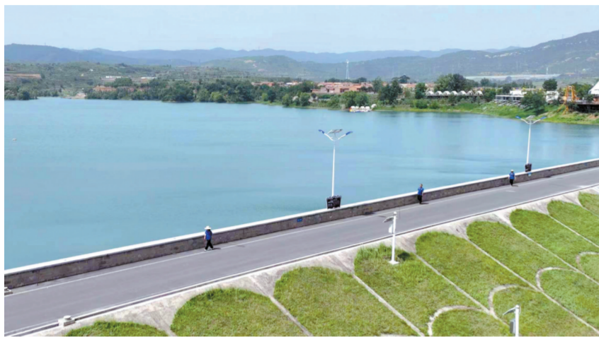
在郭庄水库,工作人员沿堤坝开展巡回检查。 郭佳雨 摄
