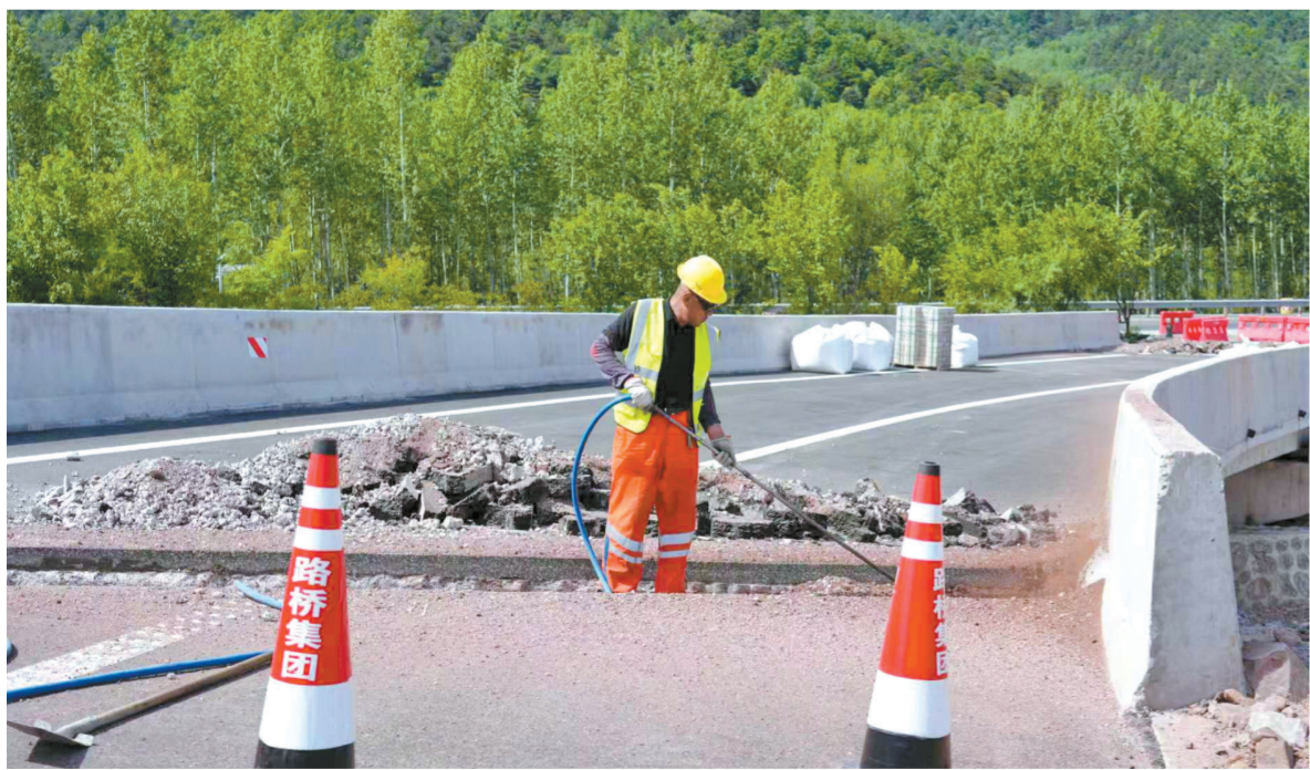
施工人员正在清理槽沟。 王建芳 摄
