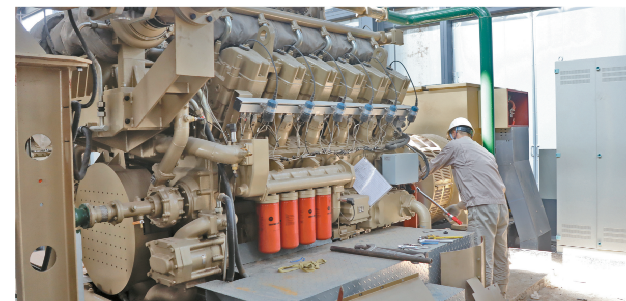
工人正在调试设备。
