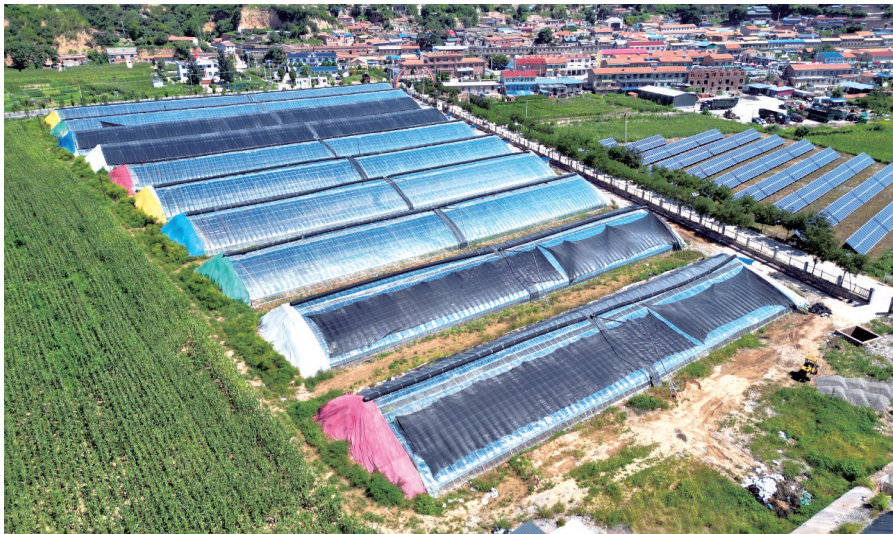
东冶头镇农旅产业园日光温室大棚整齐排布。 梁译方 摄
