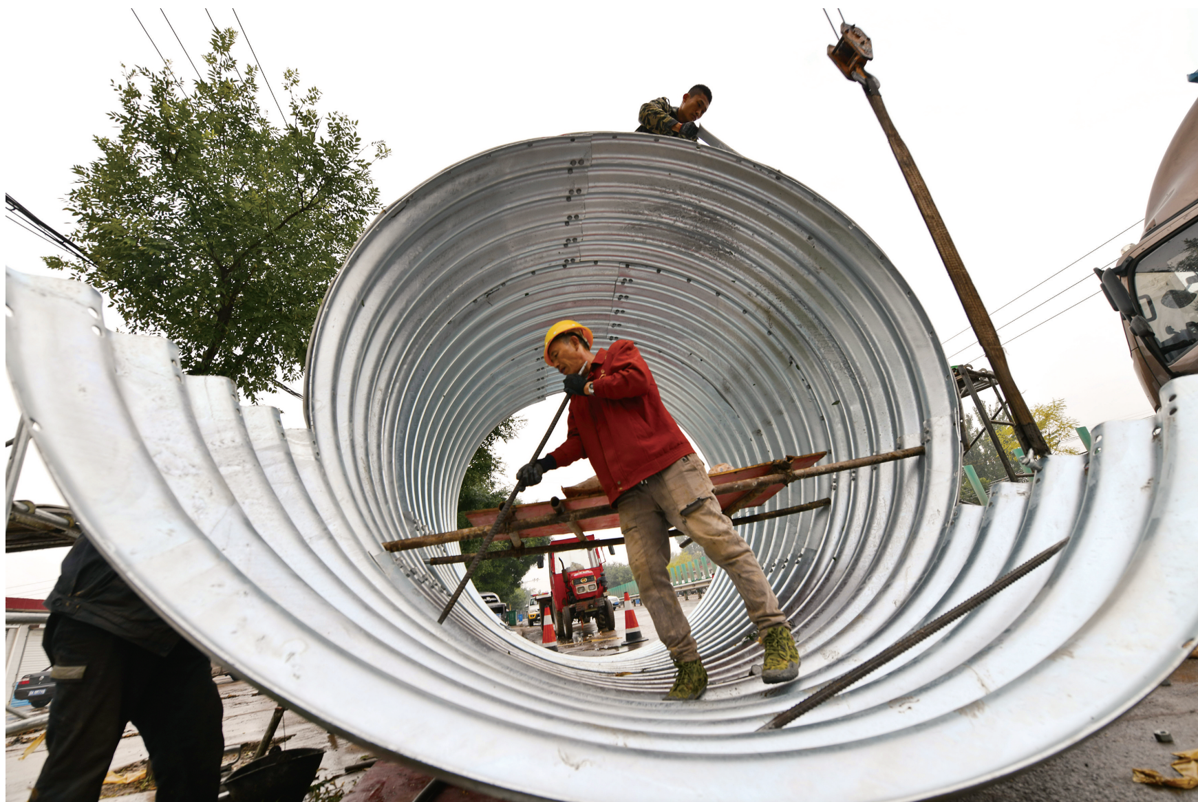
10月14日,208国道祁县鲁村桥抢修现场,工人正在组装钢波纹管。 记者 杨洋 摄
