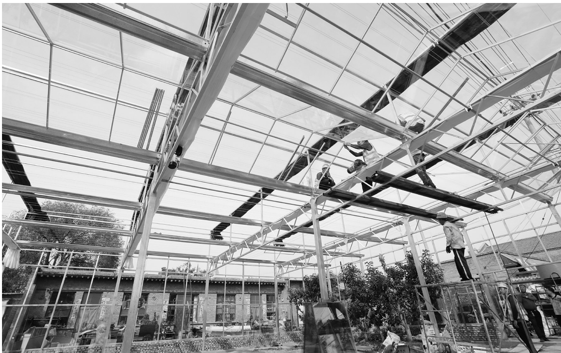
11月14日，在寿阳县西洛镇道坪村，工人正在搭建高标准文洛型玻璃温室。作为盆景果木道坪基地之一，文洛型玻璃温室配有外遮阳、内保温、集露等配套系统，让游客在严冬依然能够看到绿意盎然的植物，体验原始农业的新景观。
