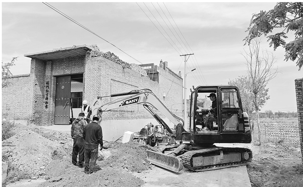
工作人员正在张原村进行开挖作业。 通讯员 李志强 摄
