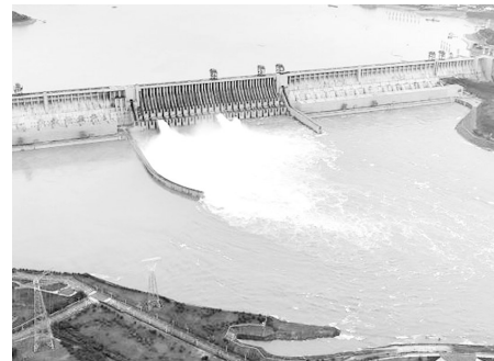
7月10日，长江三峡枢纽开启泄洪深孔泄洪（无人机照片）。新华社 王辉富 摄
