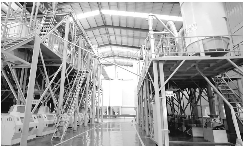
全自动化生产车间 通讯员 薛志佳 摄
