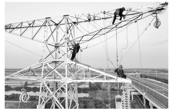
近日,位于浙江省杭州湾上虞经济技术开发区的220千伏绍嘉输变电工程进入最后攻坚阶段。为 避开高温,一线施工人员在清晨开展放线作业。
