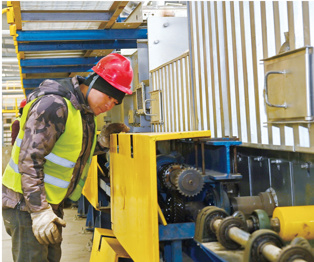
和顺图晟150t/d交通工具玻璃项目新建厂房里,工人正在调试设备。 记者 杨洋 摄
