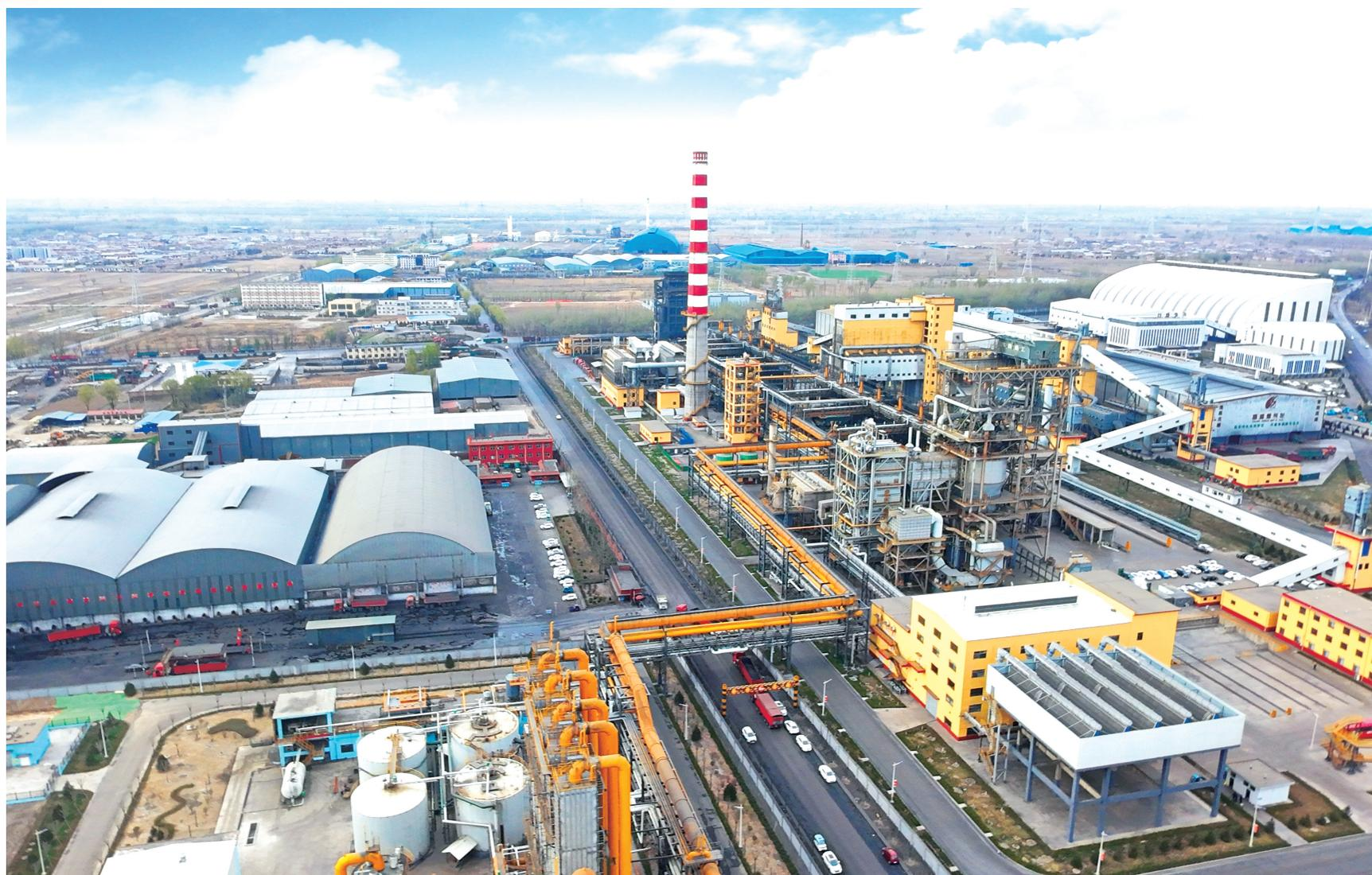
介休市昌盛煤气化有限公司年产180万吨焦化联产25万吨甲醇项目,总投资61.6亿元。2024年10月该项目正式投产以来,通过精循环利用炼焦伴生的焦炉煤气,每小时可制取优等甲醇30吨,开创多项行业第一,生产出的甲醇纯度可达99.99%,不仅实现了焦化工业清洁生产,提高了焦炉气产品附加值,更大幅提升了甲醇的生产能力。
